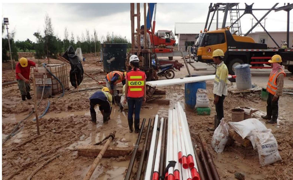
รูปที่ 3.7-8 การขุดเจาะและติดตั้งท่อรางในแนวตั้งสำหรับวัดการเคลื่อนตัวของมวลดินในแนวราบ
